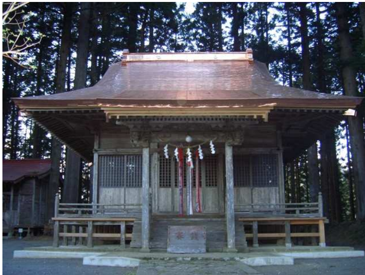
新しく銅板に吹き替えられた御社殿
